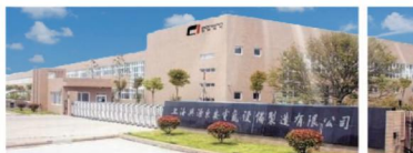
生产基地：上海兴源东安电气设备制造有限公司 定位：标准化、规模化生产 Production base— Shanghai Xingyuan DongAn Electric Co., Ltd Orientation: standardization and large-scale
