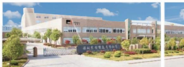
生产基地：扬州东安电气有限公司 定位：标准化、个性化定制 Production base— Yangzhou DongAn Electric Co., Ltd Orientation: standardization and customization
